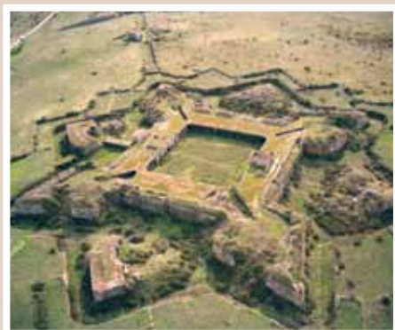
VISTA AÉREA DEL FUERTE DE LA CONCEPCIÓN
